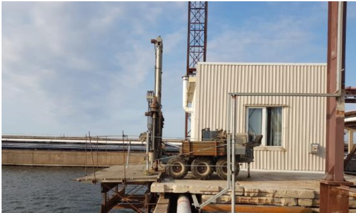
2.attēls. Statiskās un dinamiskās zondēšanas darbi objektā.
